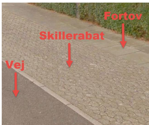
Boligvej med skillerabat i SF-sten og fortov i fliser
